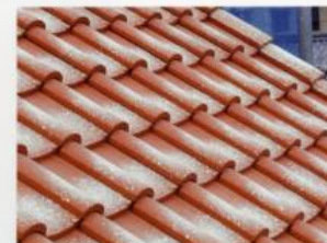
袖瓦と棟瓦の置き足が揃う
