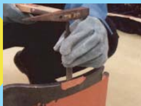
支持金具が当たらないように瓦を削る様子
